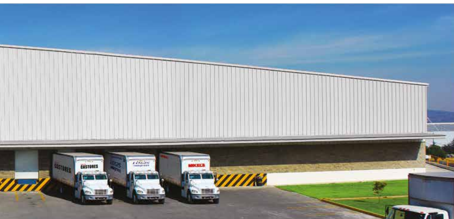
Racks de última generación
